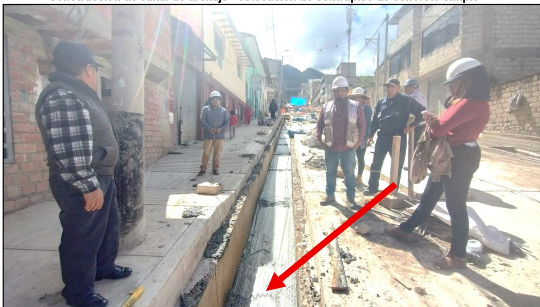
Fotografía n.º 6 Construcción de canal de drenaje - colocación de contrapiso de concreto simple
