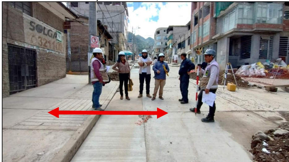
Fotografía n.º 1 Piso terminado de vereda al mismo nivel de la calzada, con rampa entre los dos elementos
