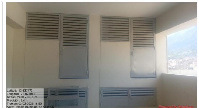
Imágenes n.ºs 6 y 7 Falta de luminarias en cuartos de máquinas de ascensores
