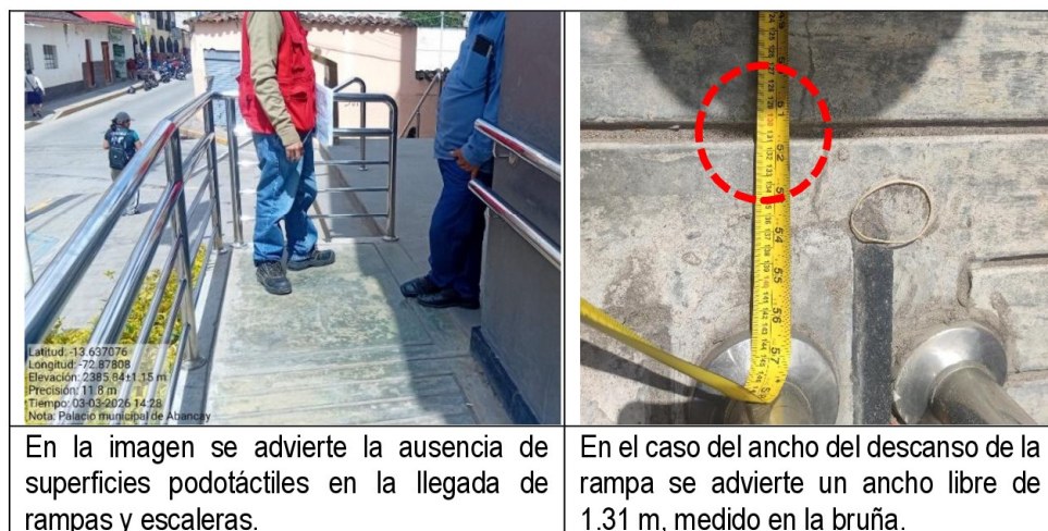
Imágenes n.ºs 56 y 57 Acabados y dimensiones de la rampa en ingreso
