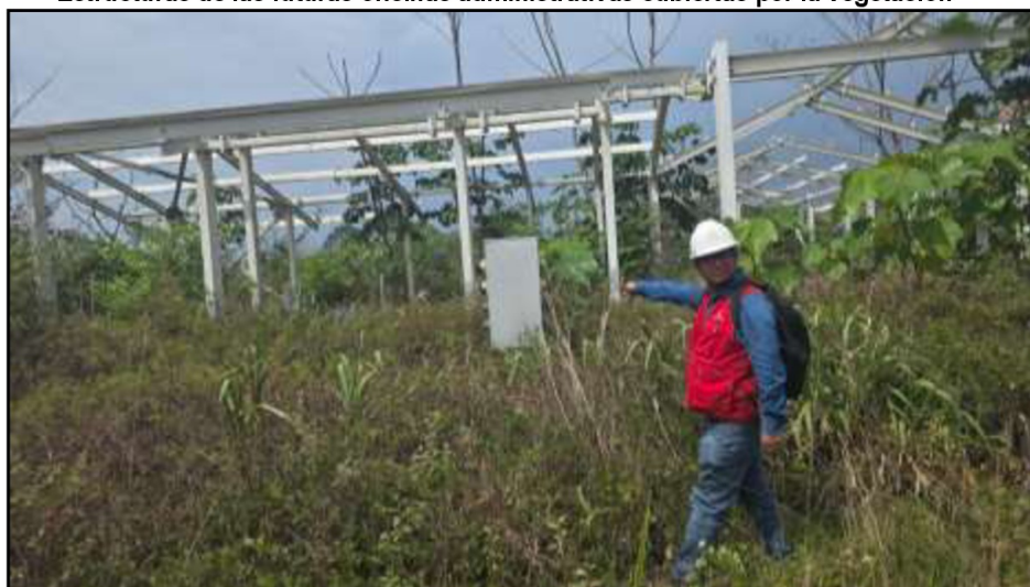
Imagen n.º 7 Estructuras de las futuras oficinas administrativas cubiertas por la vegetación
