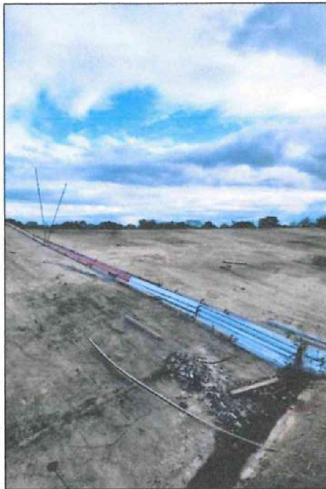
Imagen n.º 6 Junta entre bloque E y F
