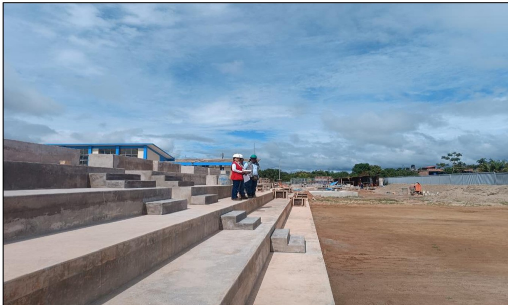
Imagen n.° 16 Vista del Polideportivo
