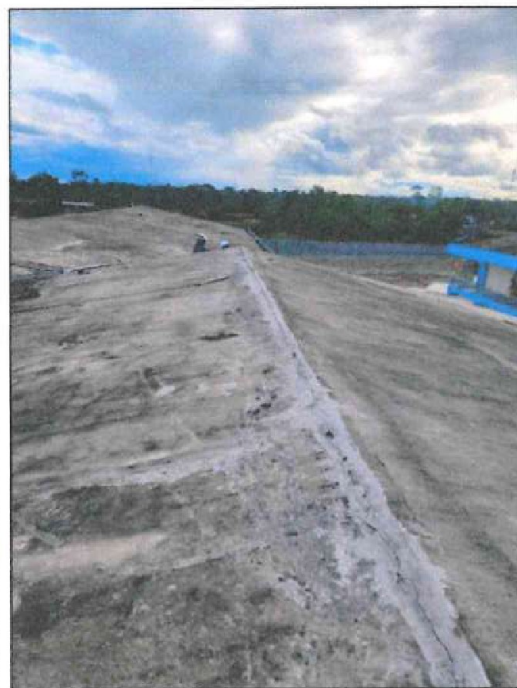
Imagen n.º 9 Junta entre el bloque E y B
