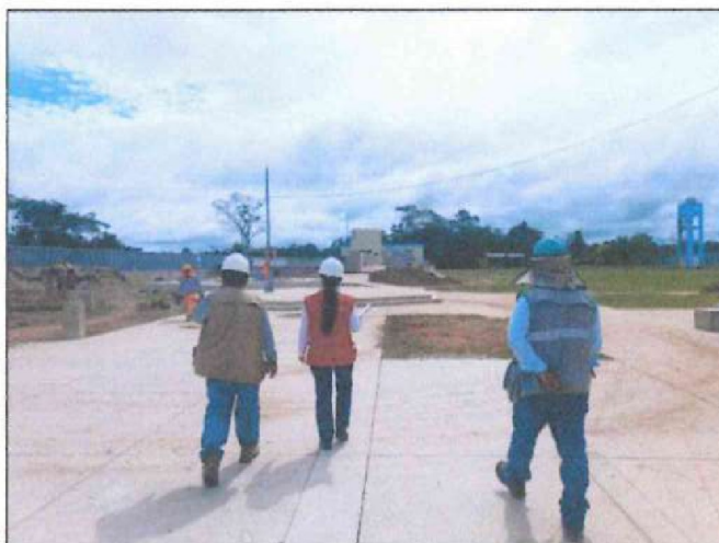
Imagen n.º 1 Inicio de la inspección de la Obra
