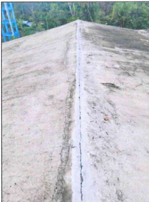
Imagen n.º 8 Junta entre el bloque E y B
