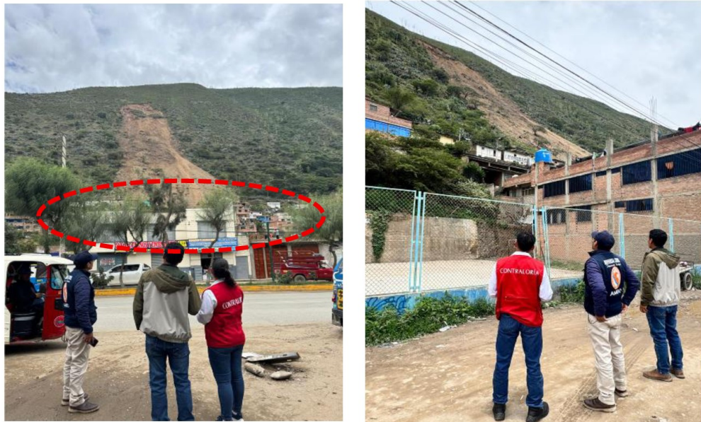
Fuente: Acta de inspección física de 25 de febrero de 2026 (11:30 horas). Elaborado por: Comisión de Control
