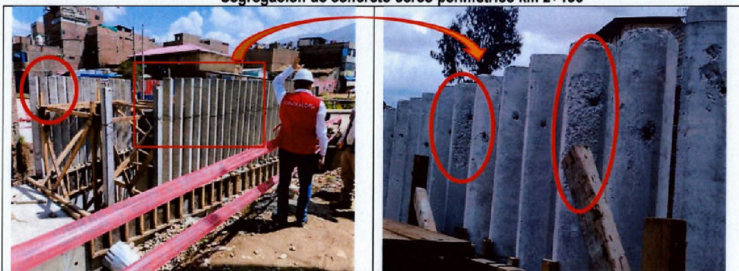
Fotografía n.º 24 Segregación de concreto cerco perimétrico km 2+156
