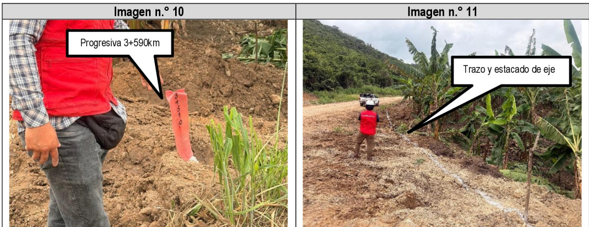
Imagen n.º 10 : Progresiva 3+590km de la línea de conducción.
