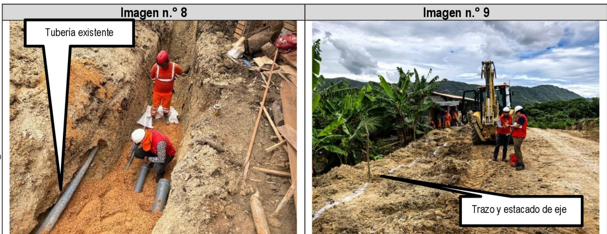
Imagen n.º 8 : Tuberías instaladas en la zanja, de diámetros 38 mm, 110 mm y 160 mm. Tubería existente en pared de zanja.
