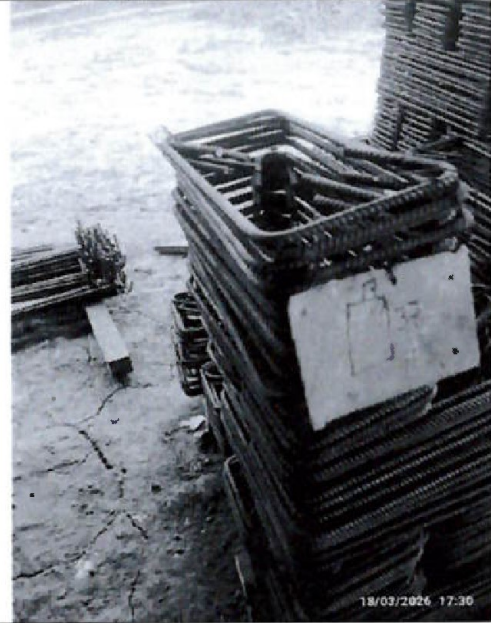
Dentro de los ambientes provisionales destinado a almacenamiento de varillas de aceros, se observan el armado de las estructuras destinadas para columnas, estribos, mechas, entre otros.
