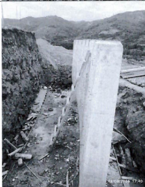
Muro de Contencion construido adyacente al acceso principal, como parte del sostenimiento del terreno donde se ejecutaran las edificaciones del centro de salud.
