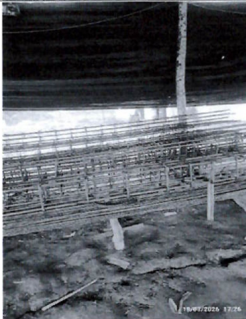
Dentro de los ambientes provisionales destinado a almacenamiento de varillas de aceros, se observan el armado de las estructuras destinadas para columnas, estribos, mechas, entre otros.
