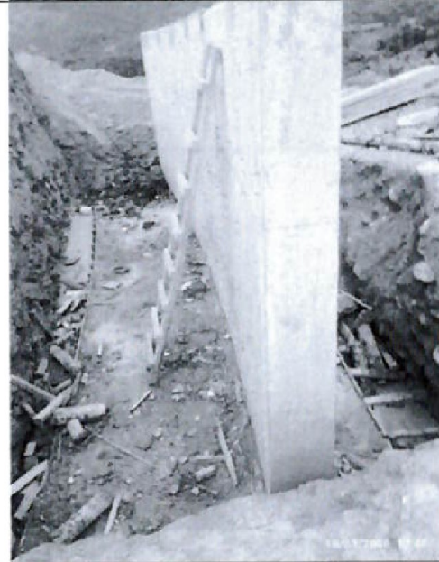
Muro de Contencion construido adyacente al acceso principal, como parte del sostenimiento del terreno donde se ejecutaran las edificaciones del centro de salud.
