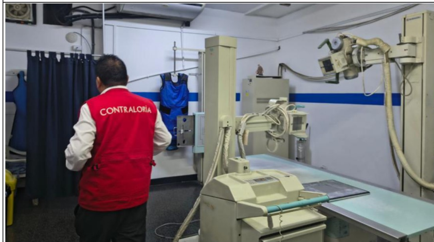
Toma fotográfica N° 14 Sala de Rayos X
