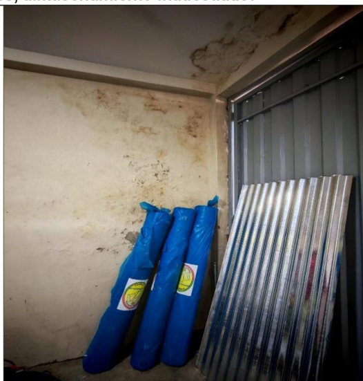
Foto n.º 8.- Material en el piso
