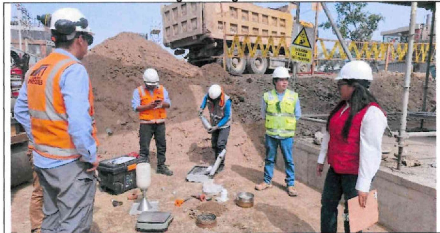
Realización de ensayo de densidad de campo – Cono de arena.
