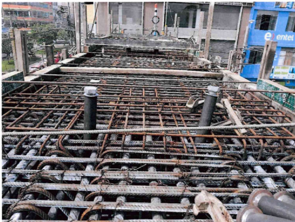
Pilar P7-AB, evidenciándose presencia de oxido en el acero estructural de su capitel.
