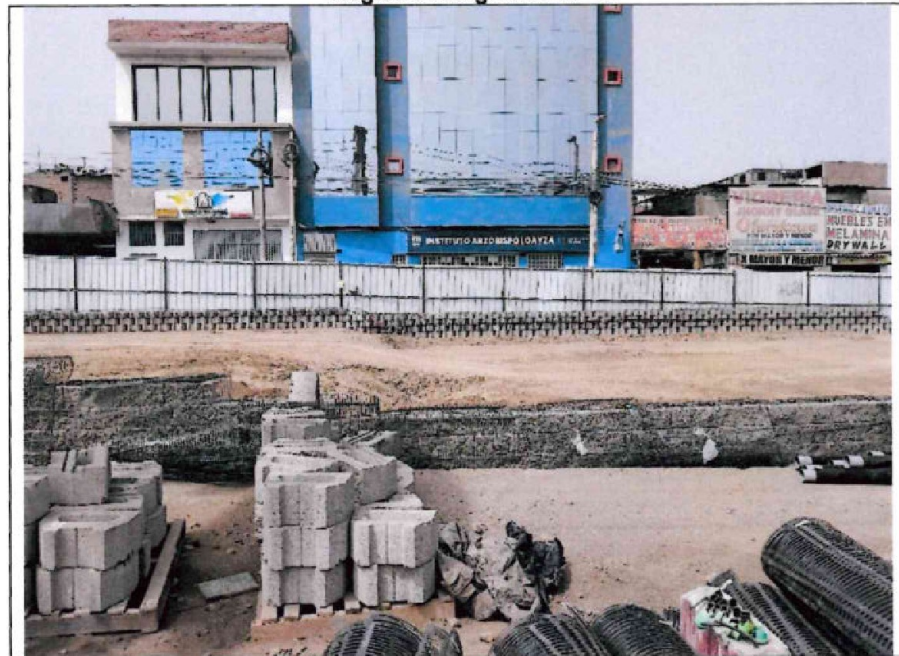
Conformación de material de relleno para la rampa de acceso (lado sur).
