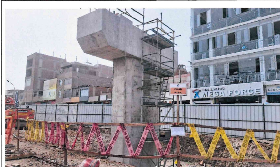
Pilares P16-A, P14-A y P15-A.
