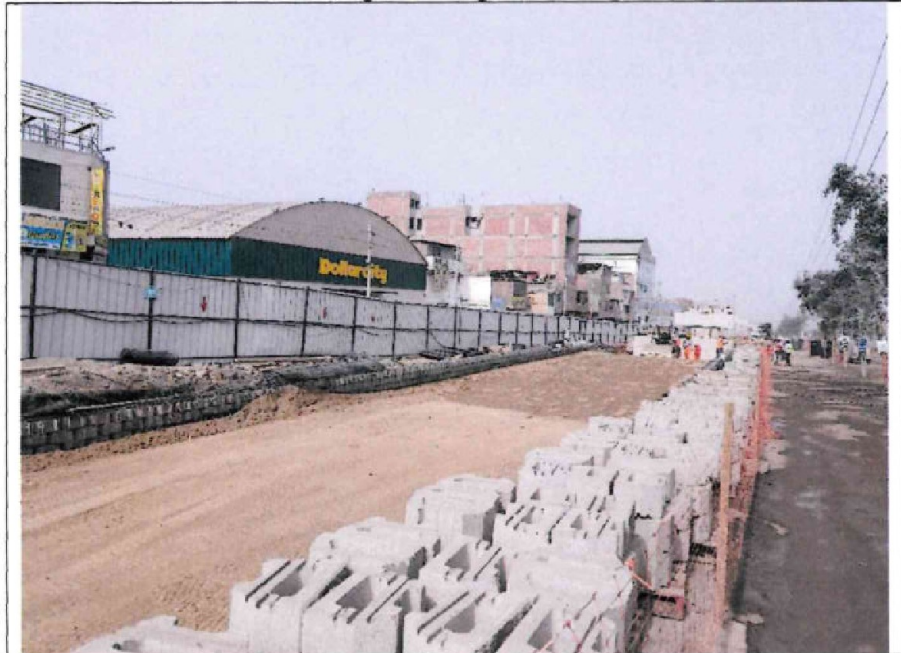
Conformación de material de relleno para la rampa de acceso (lado norte).
