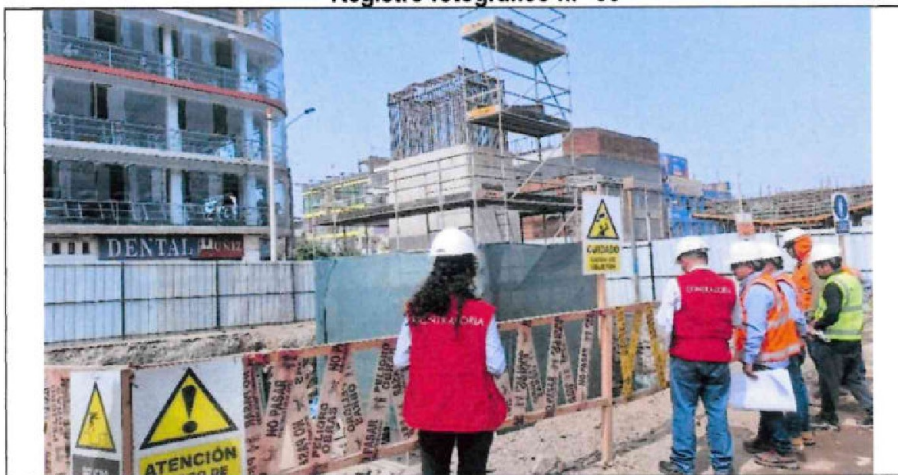
Señalización del área de trabajo.
