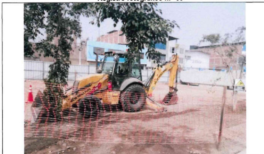
Maquinaria pesada en Obra.
