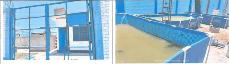
Imágenes N° 5, 6, 7 y 8: Camara de reunion agua potable, linea de conduccion, se observa el deterioro y oxidación de las tuberías debido al salitre, al clima salino de la costa y a la paralización de la obra.
