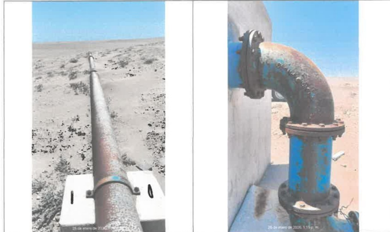
Imágenes N° 5, 6, 7 y 8: Camara de reunion agua potable, linea de conduccion, se observa el deterioro y oxidación de las tuberías debido al salitre, al clima salino de la costa y a la paralización de la obra.
