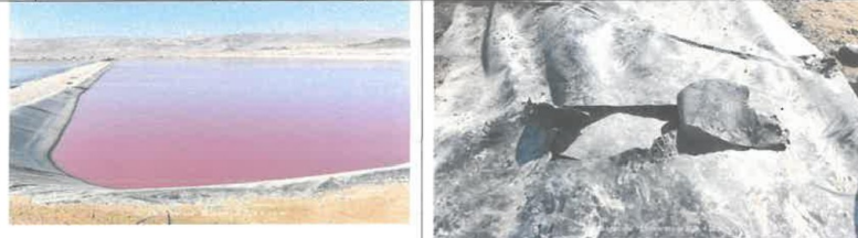
Imagen N° 15: Una de las 6 pozas de del sistema de lagunas de la PTAR. Tres del lado izquierdo (zona norte), están operativas y las otras tres no.
