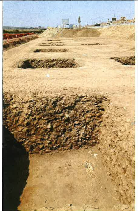
Fotografía N° 6: Vista de la capa superior en el arranque del pilotaje en el estribo izquierdo del puente santa rosa, se aprecia el suelo de relleno con presencia de materia contaminante.
