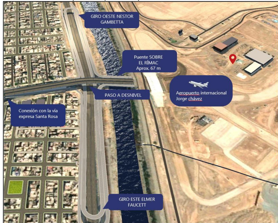
Imagen N° 2 Componentes que forman parte del Puente Santa Rosa
