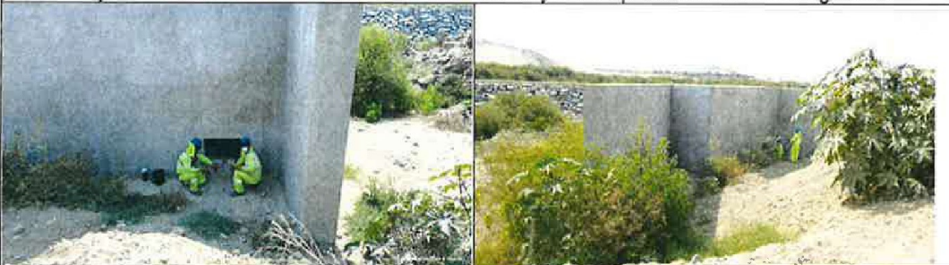
Trabajo de limpieza de fierros oxidados en estructura
