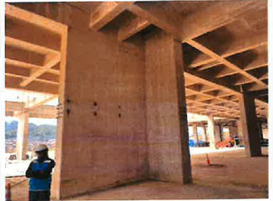
Fotografía N° 12: Vista de la zona de anclaje de las estructuras metálicas del mezanine en el piso 1 del Procesador Central del Terminal de Pasajeros.
