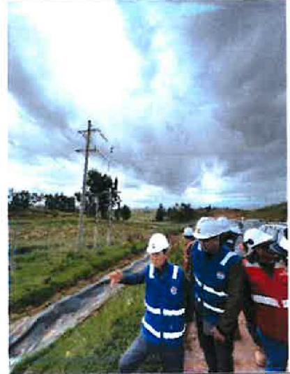
Fotografía N° 28: Vista de cerco perimétrico faltante junto a la salida de la red eléctrica del buzón en Racchi Ayllu.
