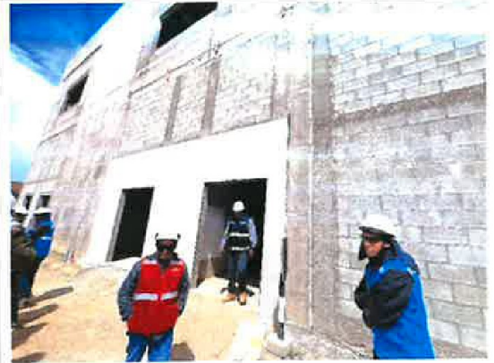
Fotografía N° 14: Vista la prueba de revoque de mortero sobre muro exterior del Dique Sur del Terminal de Pasajeros.
