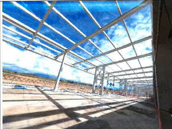
Fotografía N° 17: Vista de estructuras metálicas del Bloque F del Dique Sur del Terminal de Pasajeros en el nivel 2.
