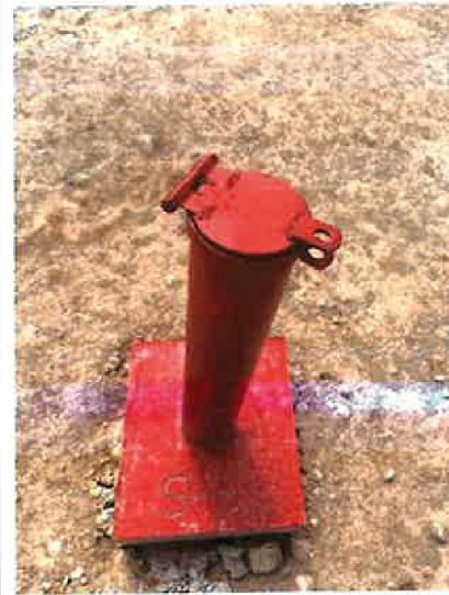
Fotografía N° 6: Vista de piezómetro S-9 en el exterior del Bloque A, Dique Norte del Terminal de Pasajeros, visto desde el piso 1.
