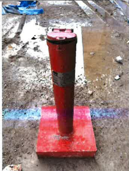
Fotografía N° 5: Vista de piezómetro S-4 en el exterior del Bloque A, Dique Norte del Terminal de Pasajeros, visto desde el piso 1.
