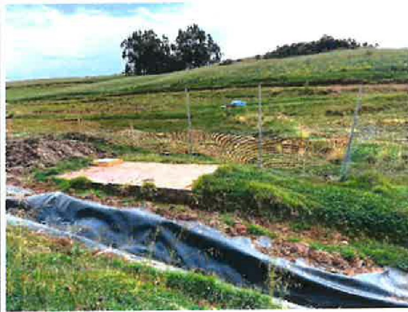
Fotografía N° 27: Vista de cerco perimétrico faltante junto a buzón eléctrico en Racchi Ayllu.
