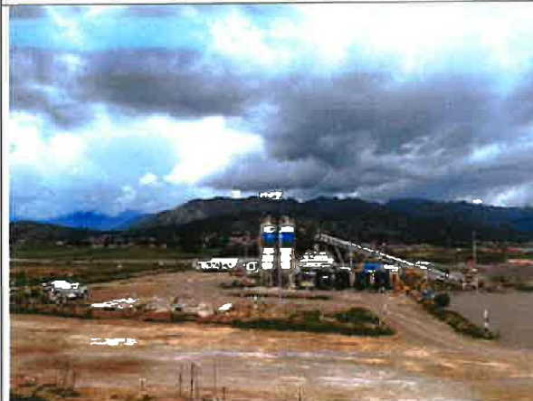
Fotografía N° 21: Vista de planta de Concreto sin actividad productivas.
