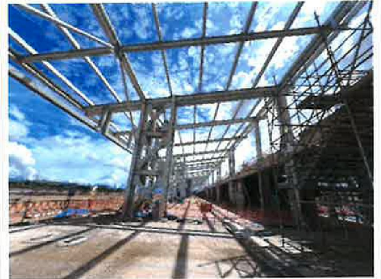
Fotografía N° 18: Vista de estructuras metálicas del Bloque E y E' del Terminal de Pasajeros en el nivel 2.
