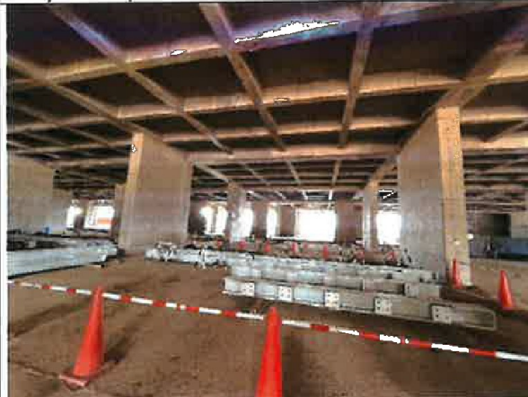
Fotografía N° 13: Vista de estructuras metálicas almacenadas para el anclaje de las estructuras metálicas del mezanine en el piso 1 del Procesador Central del Terminal de Pasajeros.
