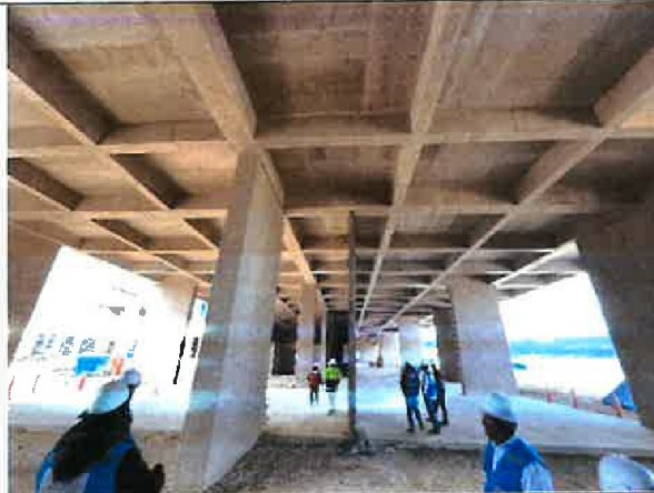
Fotografía N° 11: Vista del Bloque B del Dique Norte del Terminal de Pasajeros en donde no se viene efectuando ningún trabajo de campo durante la visita.
