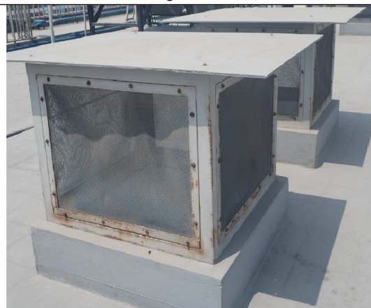
Vista de estructuras metálicas en teatina con presencia de óxido.
