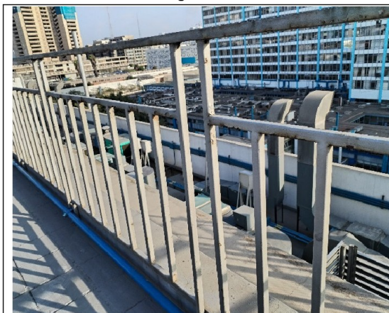
Vista de las barandas con presencia de óxido.
