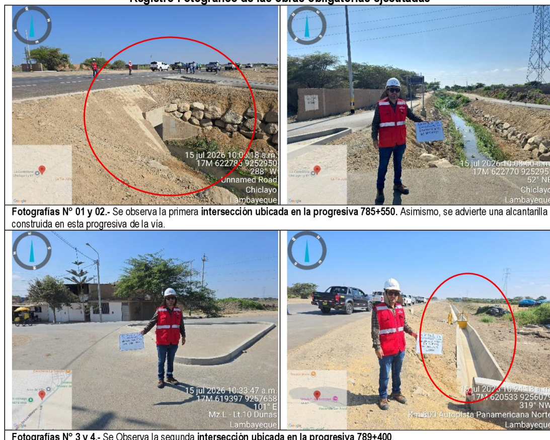
Cuadro N° 5 Registro Fotográfico de las obras obligatorias ejecutadas
