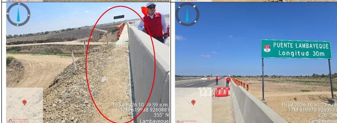
Fotografías N° 9 y 10.- Se Observa la ejecución del Puente Lambayeque en la progresiva 794+970. Asimismo, en dicho puente se constata la instalación de dispositivos de seguridad, así como la construcción de veredas e instalación de barandas a los extremos del puente.
