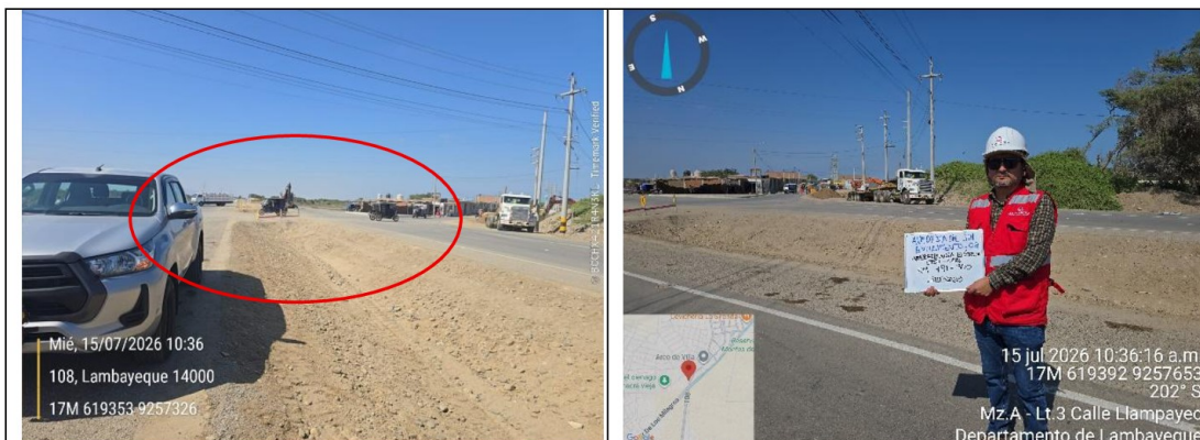
Fotografías N° 5 y 6.- Se Observa la tercera intersección ubicada en la progresiva 791+300.
