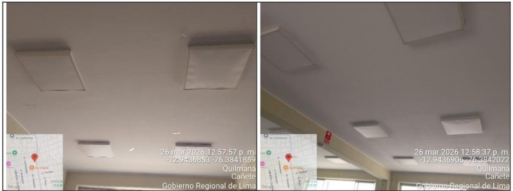
Luminaria está englobada con desgaste del material plástico
