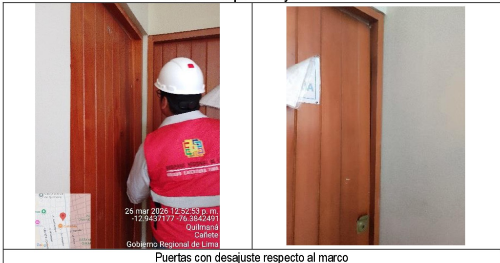
Panel Fotográfico n.º 10 Estado de componentes y elementos
