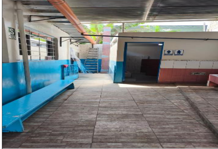
Toma fotográfica n.º 6: Área del exterior a las instalaciones de la cocina y almacén.
