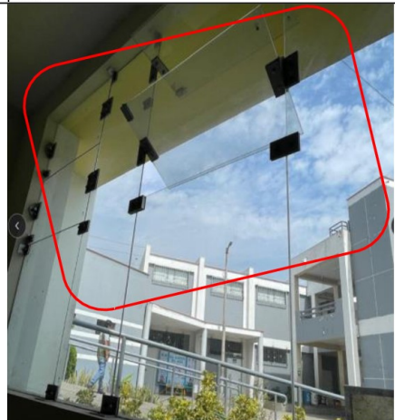
Toma Fotográfica n.º 6: Ventana no provista de mallas de protección de ingreso de plagas o polvo.
