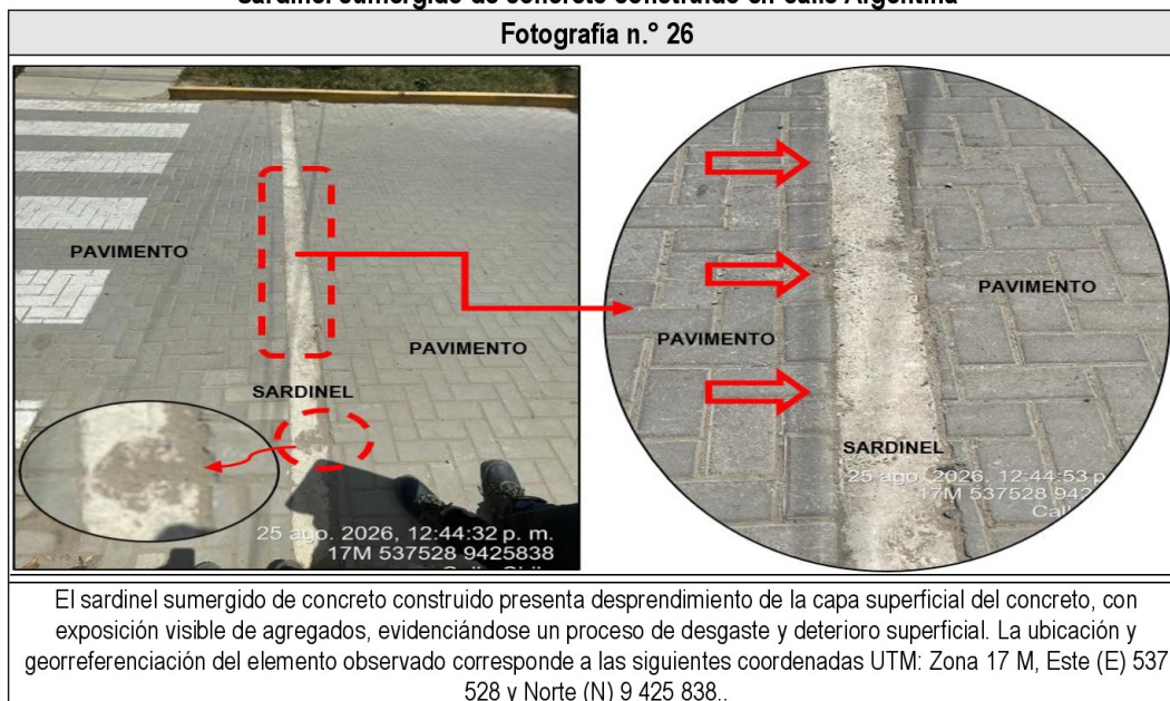
Fotografía n.º 26 Sardinel sumergido de concreto construido en calle Argentina
