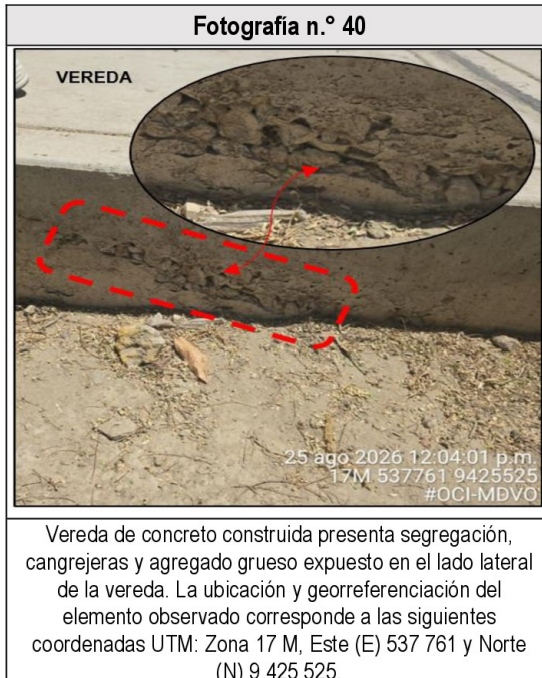
Fotografía n.º 40 Vereda de concreto construida en Av. Marcavelica
