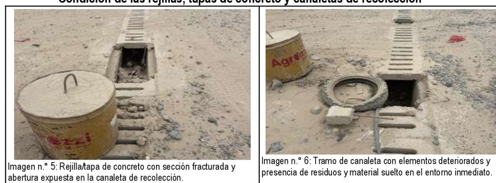
Panel fotográfico n.° 2 Condición de las rejillas, tapas de concreto y canaletas de recolección
