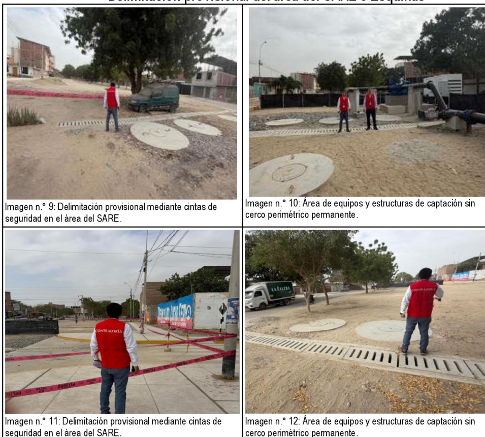
Panel fotográfico n.º 3 Delimitación provisional del área del SARE 5 Esquinas
