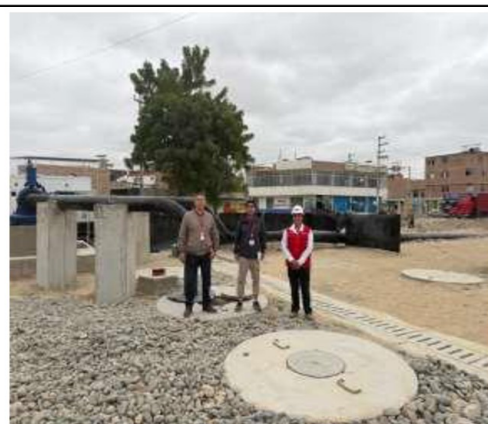
Imagen n.º 4: Registro de la visita de inspección física efectuada al SARE 5 Esquinas.
