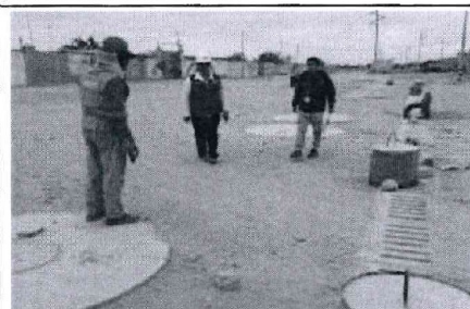
Imagen N° 4: Vista general de buzones, canaletas y elementos de captación ubicados en el área del SARE Nuevo Amanecer.
