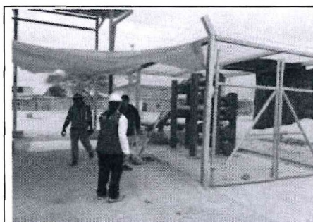
Imagen N° 1: Vista del equipamiento electromecánico del SARE Nuevo Amanecer ubicado dentro de un cerramiento metálico de malla.
