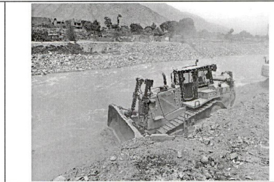
Imagen n° 23: Tractor de orugas CAT D8 trabajando en el río
