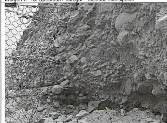
Imagen n° 12: Quebrada Pedregal – Anclajes desprendiéndose
