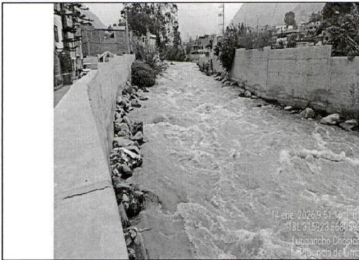
Imagen n° 9: Puente Luis La Puerta, aguas arriba
