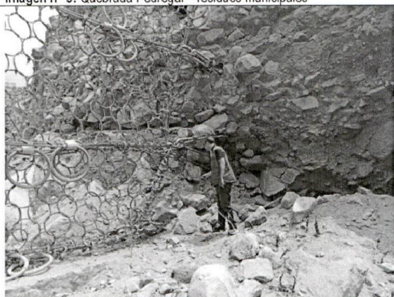
Imagen n° 11: Quebrada Pedregal – Barreras dinámicas
