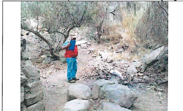
Escombros en el cauce de la quebrada Libertad desde la Carretera Central - vista aguas arriba.
