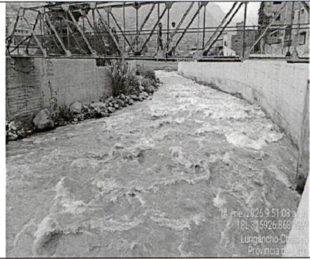
Imagen n° 10: Puente Luis La Puerta, aguas arriba
