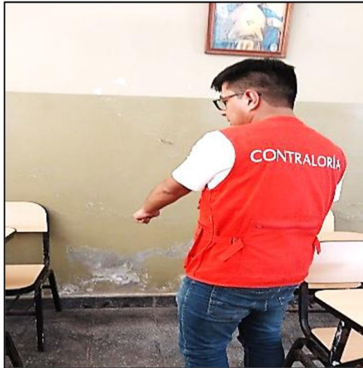
Imagen n.º 5 Paredes internas de las aulas.
