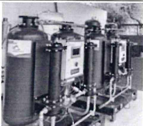
Generadores de oxígeno de la planta n.º 1
