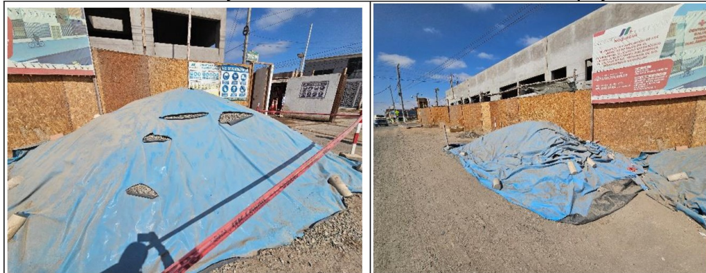
Imagen n.º5: Piedra chancada de ½ " se encuentra almacenada en el exterior de la obra.
