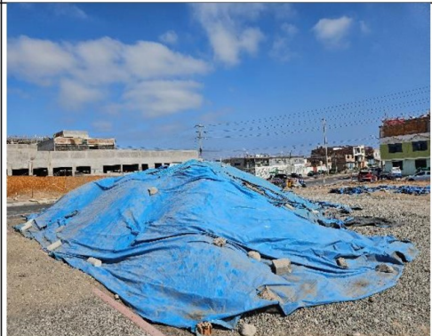
Imagen n.º8: Vista posterior de la piedra chancada de ¾" se encuentra almacenada en el exterior de la obra, pasando la calle
