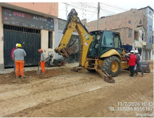
Trabajos de limpieza y eliminación de desmonte con maquinaria, ubicado en la Av. La Mar.
