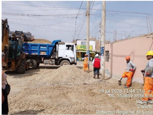
Trabajos de limpieza y eliminación de material excedente con maquinaria.
