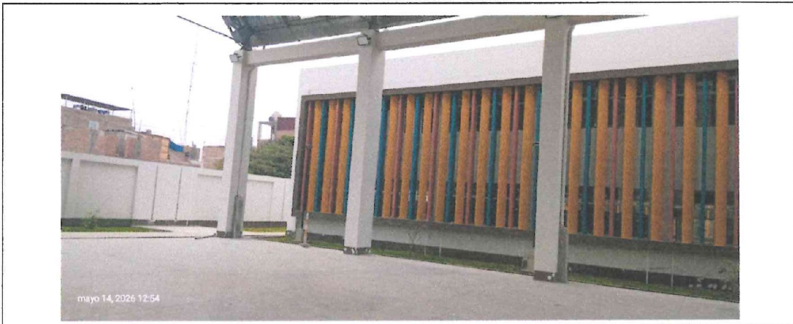
Patio de la Institución Educativa culminado, en retoques de pintura.
