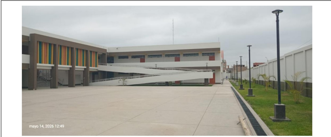
Patio central de la Institución Educativa concluido.
