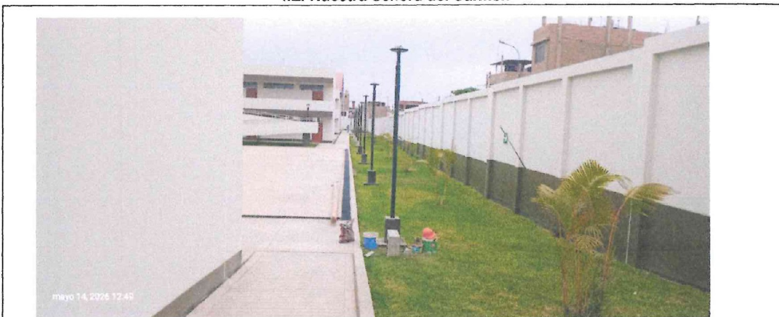
Ingreso al patio central de la Institución Educativa con material por retirar.
