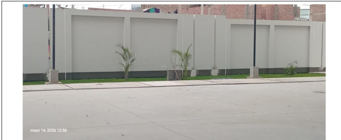
Muro lateral de la Institución Educativa culminado con partes resanadas por pintar.
