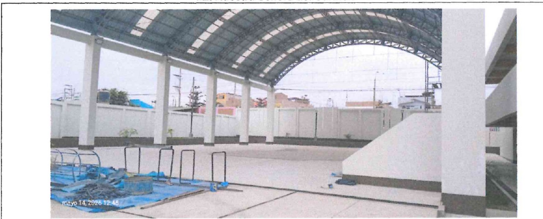
Patio techado de la Institución Educativa con materiales por retirar.
