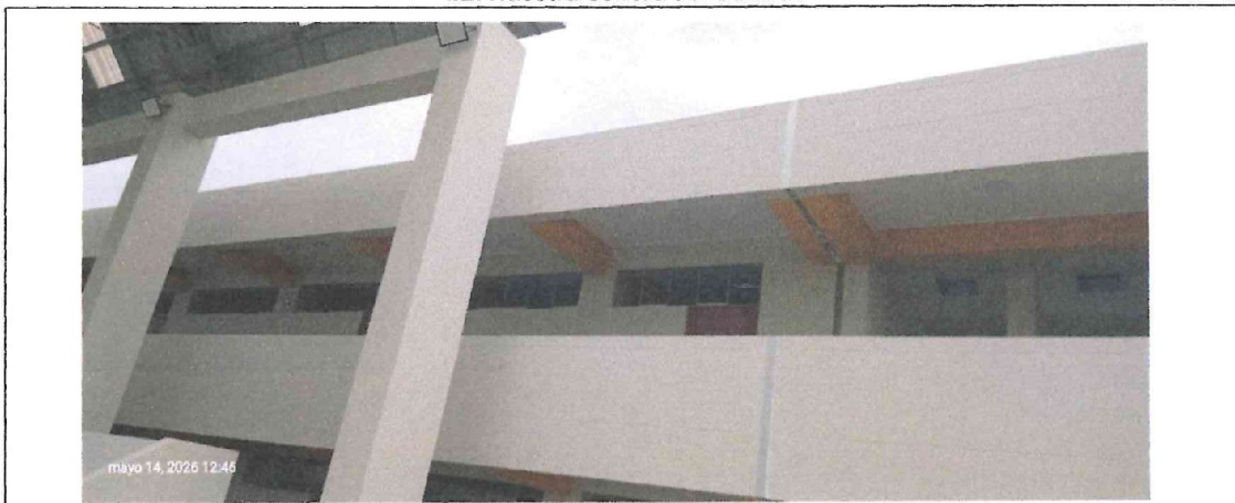
Segundo piso de pabellón de la Institución Educativa culminado.
