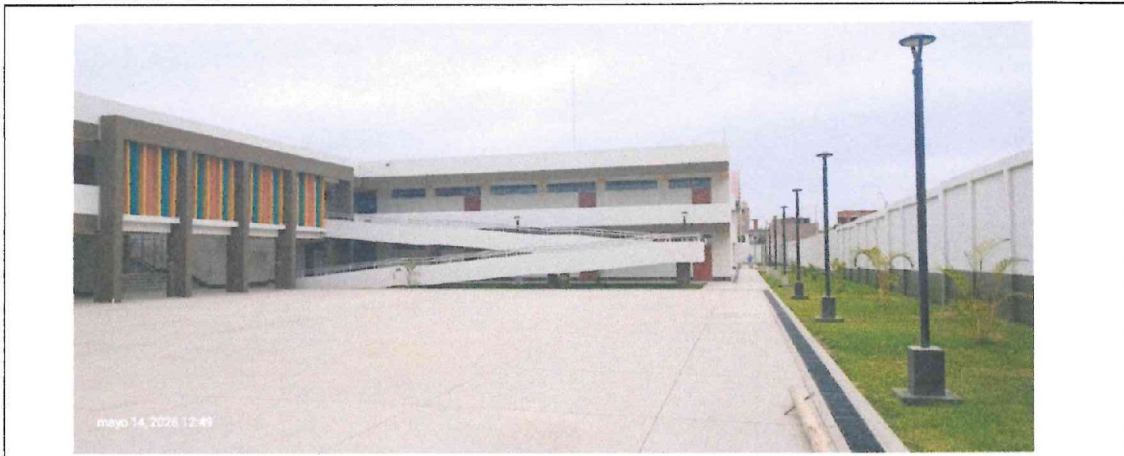
Patio central de la Institución Educativa concluido.
