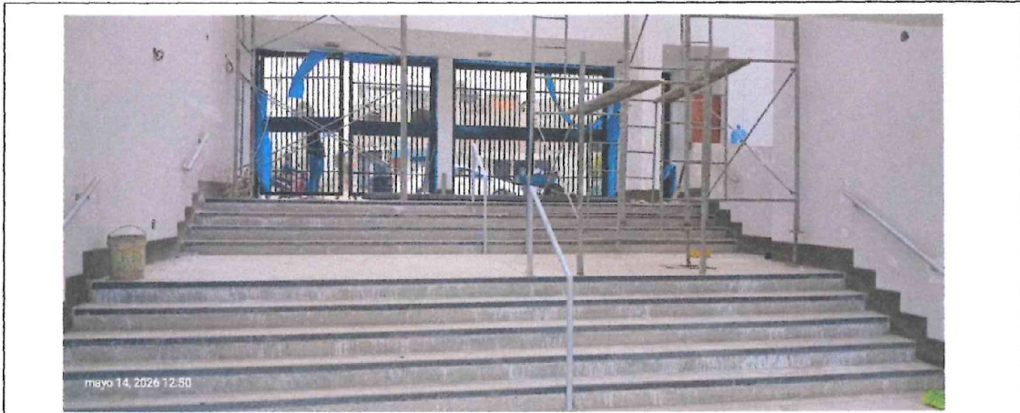
Vista panorámica de la entrada principal a la Institución Educativa en proceso de retoques de pintado.
