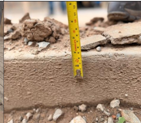
Imagen n.º 5. Se observa la altura de corte de juntas de contracción de 3 mm.
