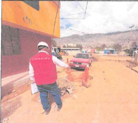
Imagen n.º 5. Se observó que el buzón ubicado en la intersección de la calle sin nombre n.º 88 y la Av. Regional, con deficiente implementación de las medidas de seguridad
