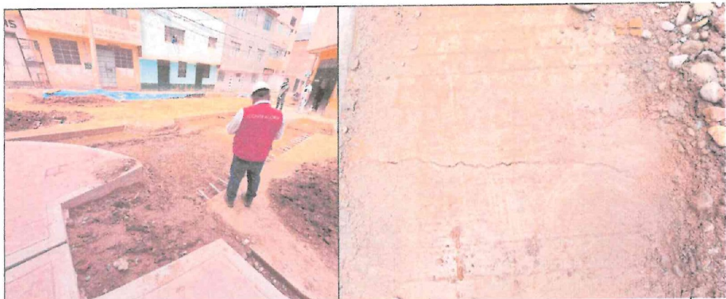
Imagen n.º 2. Presencia de fallas fisuras en pavimentos de concreto correspondiente al pasaje sin número n.º 0339.
