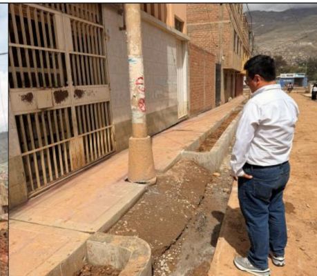
Imagen n.º 3. Se observa los postes dentro de las veredas obstruyendo el libre acceso ubicado en la calle sin nombre n.º 88 destinadas para su remplazo y reubicación.
