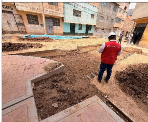
Imagen n.º 9. Se observa la falta de culminación de colocado de concreto en pavimentos, cunetas y rampas
