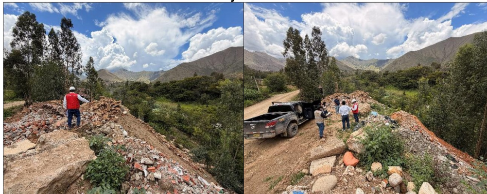
Imagen n.º 1. Se observa la vista fotografía del DME, sin la implementación de trabajos de mitigación ambiental y con presencia de bloques de concreto ladrillo y escombros
