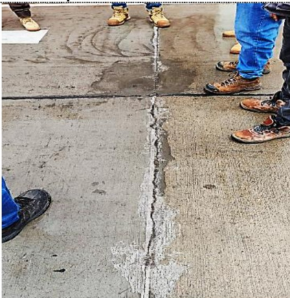
Fotografía N° 17. Km 0+320 Se verificó resane defectuoso de corte en el pavimento
