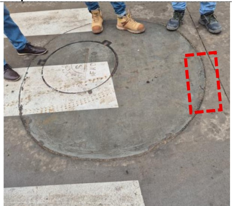
Fotografía N° 6. Km 0+640. Fisuras en el concreto
