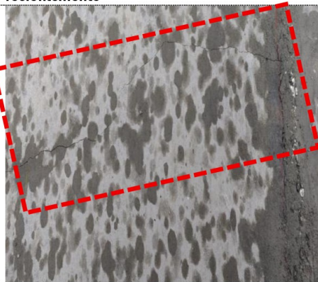
Fotografía N° 29. Km 0+010. Fisura longitudinal en un paño de la losa de concreto, que había sido vaciado recientemente
