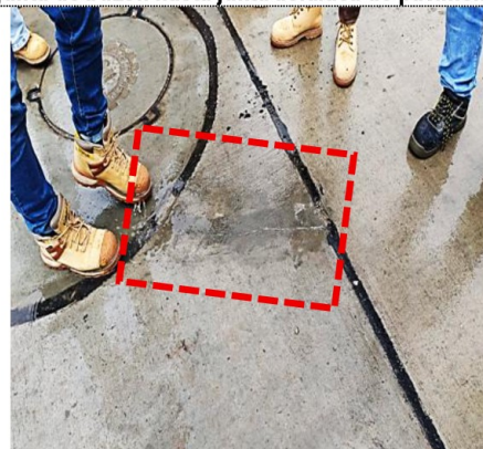
Fotografía N° 18. Km 0+320 Juntas defectuosas, tanto las realizadas con corte y las rellenas con asfalto
