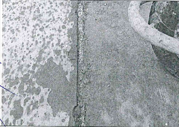
Km 0+010. Paño de concreto cortado, para vaciar parte del mismo con concreto nuevo. Vista de la junta con tecnopor
