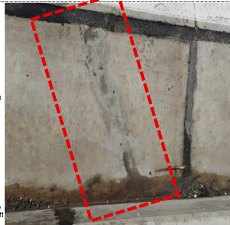
Fotografía N° 29. Km 0+010. Fisura longitudinal en un paño de la losa de concreto, que había sido vaciado recientemente
