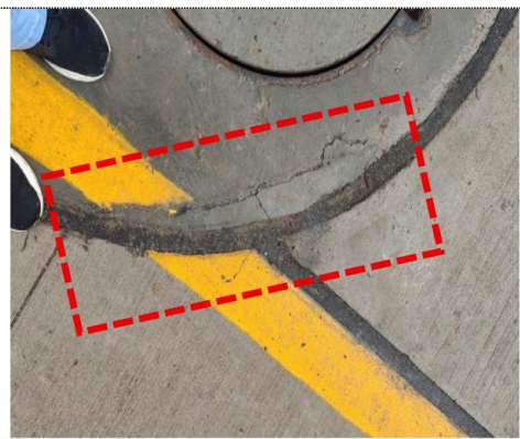
Fotografía N° 30. Km 0+240 del tramo La Chonta. La tapa un buzón se encontró fisurada
