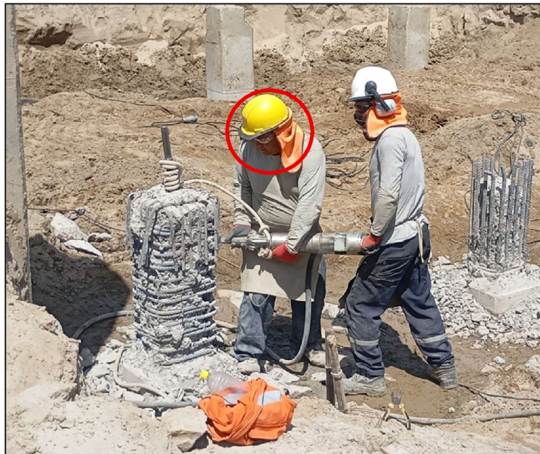
IMAGEN N° 23 DESCABEZADO DE PILOTE CON MARTILLO NEUMÁTICO
