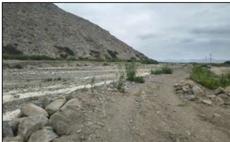
Fuente: Visita de inspección de 8 de julio de 2026.
