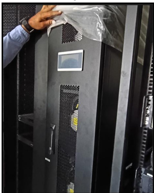
Sistema de aire de precisión para servidores
