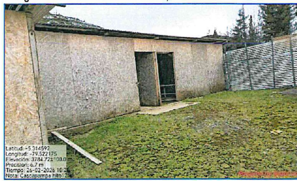
Fotografía n.º 13: Oficinas de la Obra, en malas condiciones
