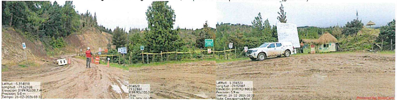
Fotografía n.º 2: Componente presa (estribo derecho), sin personal ni maquinaria.
