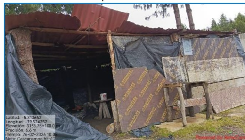
Fotografía n.º 6 Almacén 1, cerca al aliviadero
