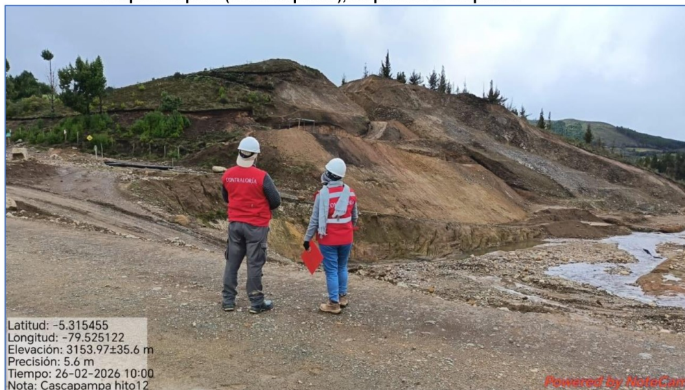
Fotografía n.º 3 Componente presa (estribo izquierdo), sin personal ni maquinaria
