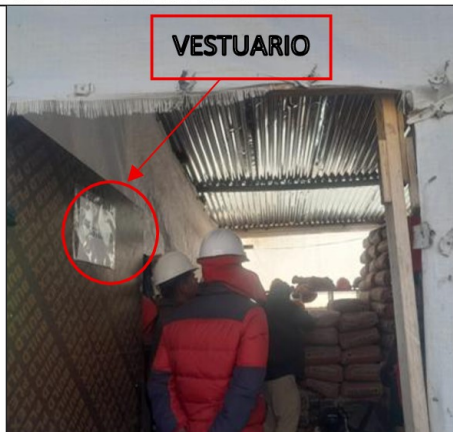
Imagen n.º 2: Cemento almacenado en el área de vestuario
