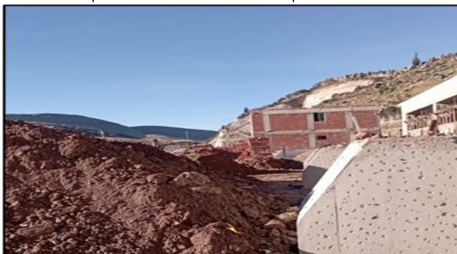
Bloquetas de ladrillo de arcilla en la intemperie
