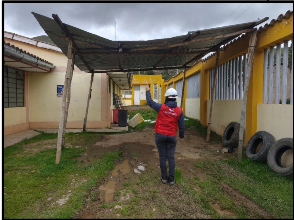
Fotografía n.º 02 Cobertura actual del estacionamiento de la ambulancia, infraestructura de contingencia
