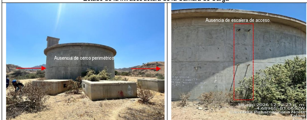
Imagen n.°s 23, 24, 25 y 26 Estado de la infraestructura de la Cámara de Carga
