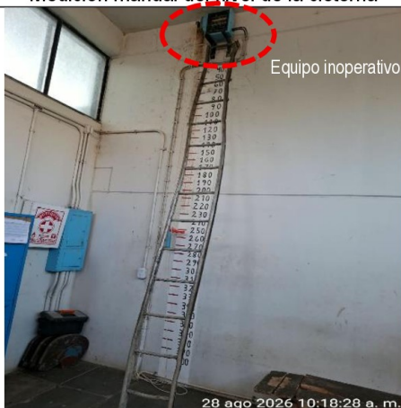
Imagen n.º 8 Medición manual del nivel de la cisterna
