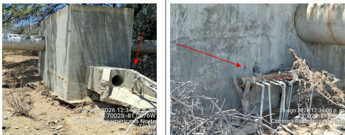
Fuente: Acta de Inspección n.° 028-2026-OCI/3470 de 28 de agosto de 2026
