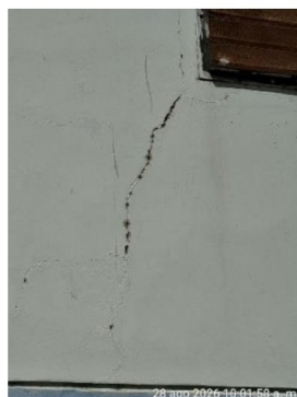
Imagen n.º 10,11 y 12 Fisuras y grietas en la infraestructura de la estación de bombeo n.º 1
