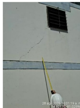
Imagen n.º 10,11 y 12 Fisuras y grietas en la infraestructura de la estación de bombeo n.º 1
