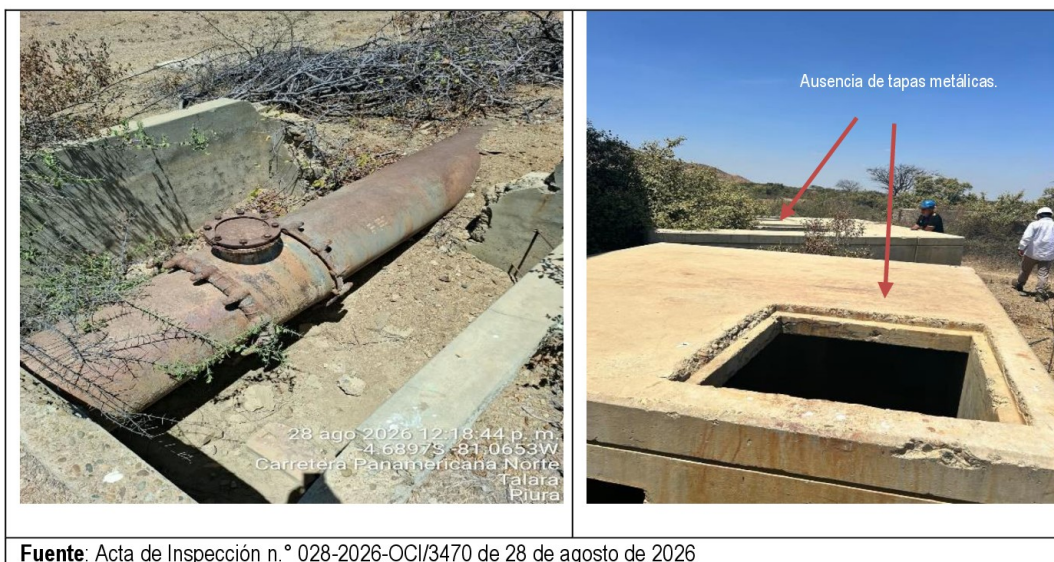
Fuente: Acta de Inspección n.° 028-2026-OCI/3470 de 28 de agosto de 2026
