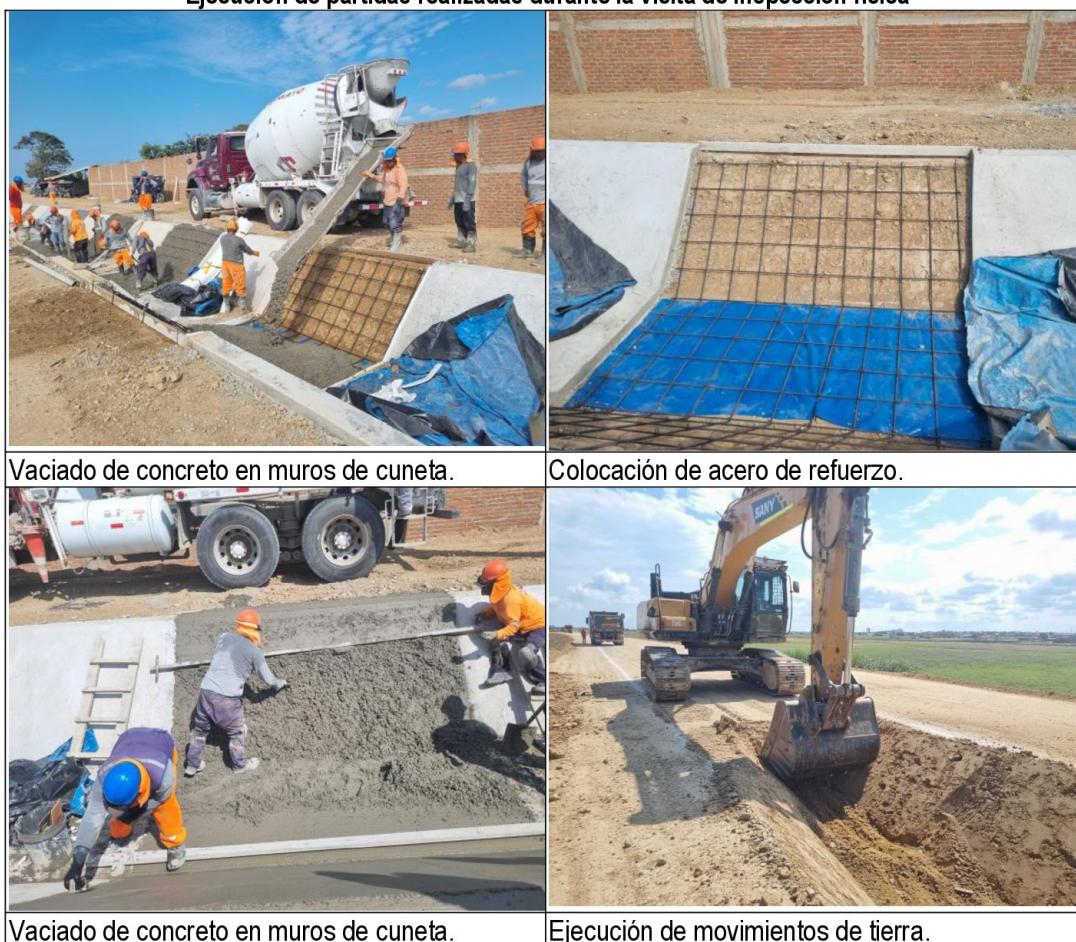
Vaciado de concreto en muros de cuneta.
