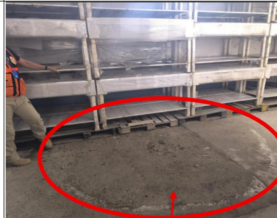
Imagen n.º 9: Piso con gotera y humedad al pie de la rotura del techo, donde aprecian bienes (cocinas) muy cerca de la misma.
