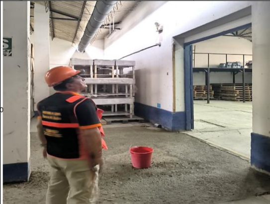
Imagen n.º 9: Piso con gotera y humedad al pie de la rotura del techo, donde aprecian bienes (cocinas) muy cerca de la misma.
