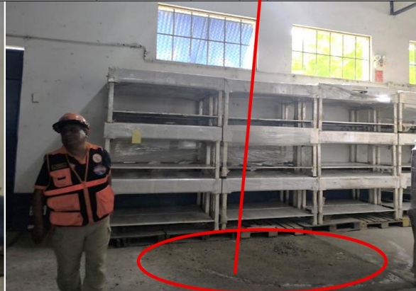
Imagen n.º 9: Piso con gotera y humedad al pie de la rotura del techo, donde aprecian bienes (cocinas) muy cerca de la misma.
