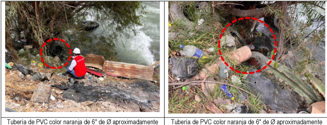
Tubería de PVC color naranja de 6" de Ø aproximadamente
