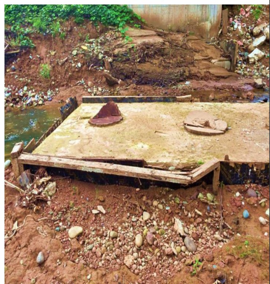
Resto de base utilizada como soporte en los encofrados, alterando y contaminando el recurso hídrico.
