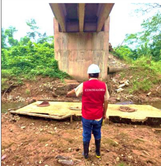
Resto de base utilizada como soporte en los encofrados, alterando y contaminando el recurso hídrico.
