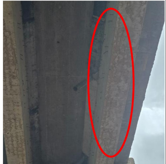
Restos de madera del encofrado en el exterior en la viga y losa de la estructura del puente.
