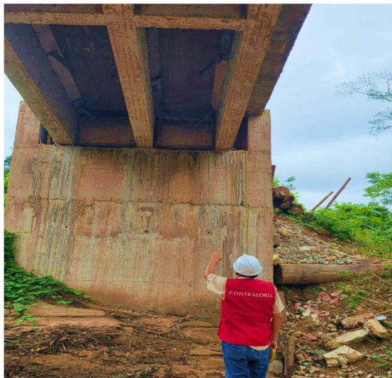
Restos de madera del encofrado en el exterior en la viga y losa de la estructura del puente.
