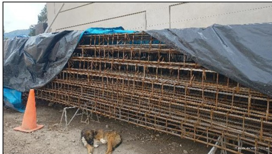
Fuente: Acta de inspección física n.° 001-2026-MDSM/OCI-SCC-TECNOLOGICO
