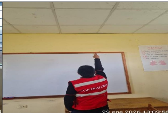
En el techo de las aulas de la IE presentan filtraciones de agua.
