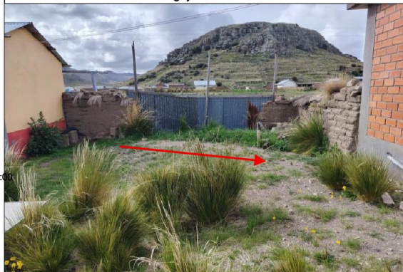
Cerco perimétrico de la IE presenta desmoronamiento en un tramo y se encuentra cercado con calamina.
