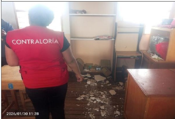
Desprendimiento del techo de cielo raso del aula de la IE.
