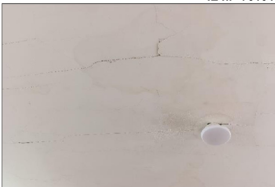
Los techos de las aulas de la IE presentan rajaduras y humedad, que podrían comprometer la seguridad de los estudiantes
