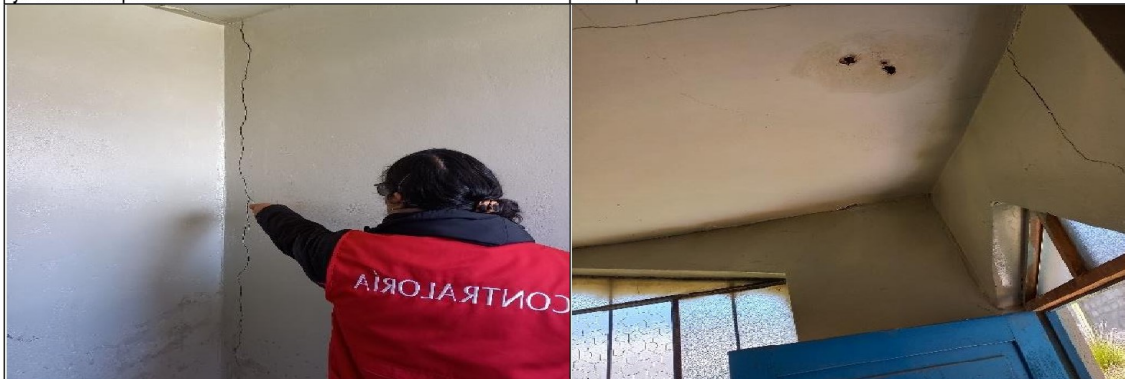
Filtración de agua en el techo, riesgo de caída del techo de aula, la cual ya fue desocupada.
