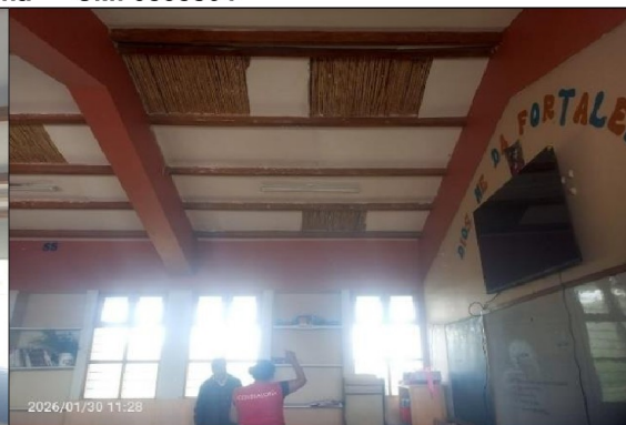
Desprendimiento parcial del techo de cielo raso de yeso en el interior de las aulas del segundo piso de la IE.
