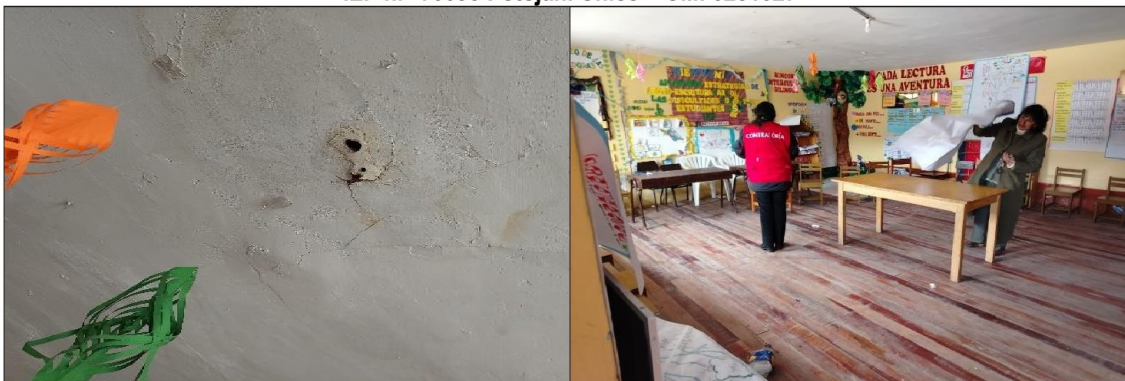
Filtración de agua en aula, genera humedad en el piso de madera.
