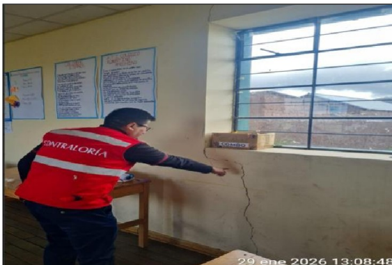
Los ambientes de la IE presentan rajaduras en las paredes.
