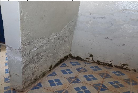
Filtración de agua en la pared del baño de mujeres.
