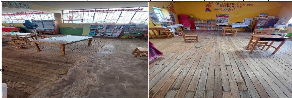
Pisos de las aulas ubicadas en el primer nivel de la institución presentan desgaste superficial del entablado, así como aberturas en las juntas
