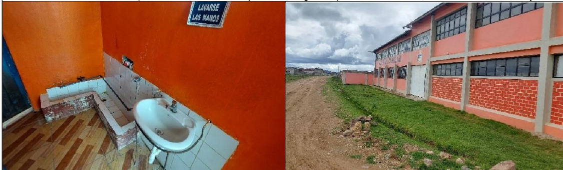
Urinario de los SSHH de estudiantes hombres cuenta con sistema de descarga improvisado y sin accesorios sanitarios adecuados
