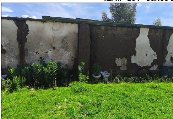
La IE presenta deterioro en el cerco perimétrico ocasionado por las lluvias recurrentes y el desgaste natural del tiempo de servicios.
