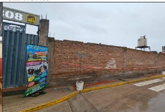
La pared del cerco perimétrico de la IE se encuentra fisurada.
