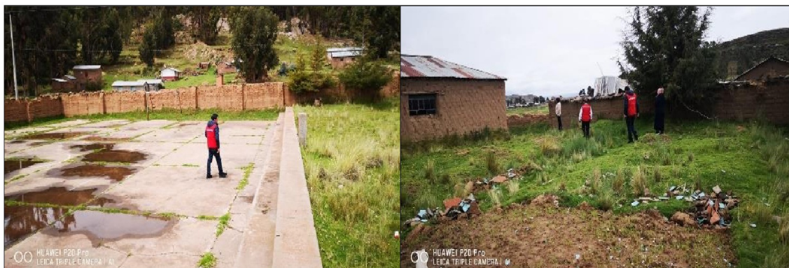
Losas deportivas con filtración y empozamiento de agua, así como presencia de vegetación en las juntas. La IE presenta residuos sólidos dentro del mismo
