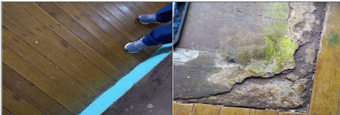
Filtración de agua en el piso del aula principal, la madera esta humeda y deterioro del piso de cemento.
