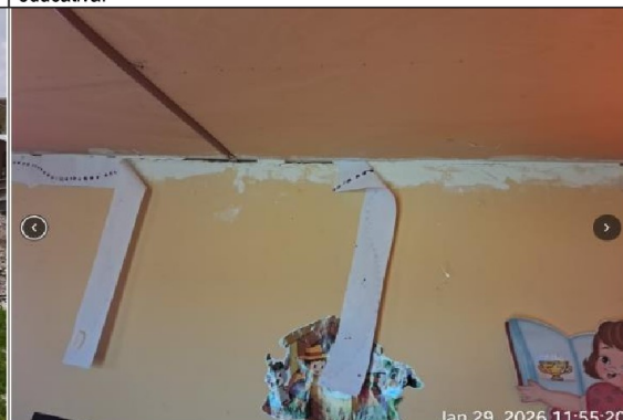
Aula se Psicomotriz internamente presenta ranuras en el techo y la pared y humedad en su interior.
