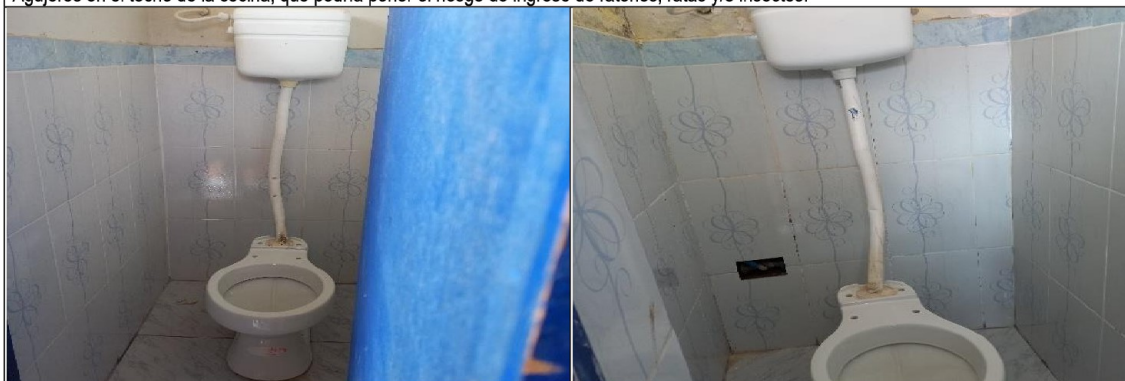
Filtración de agua por rajadura en las tuberías de conexión del tanque alto al inodoro (baño varones)
