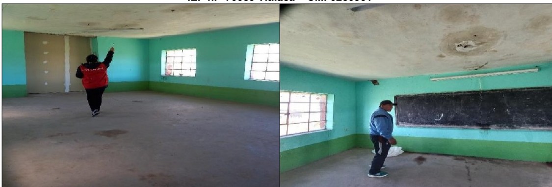
Filtración de agua en el techo, riesgo de caída del techo de aula, la cual ya fue desocupada.
