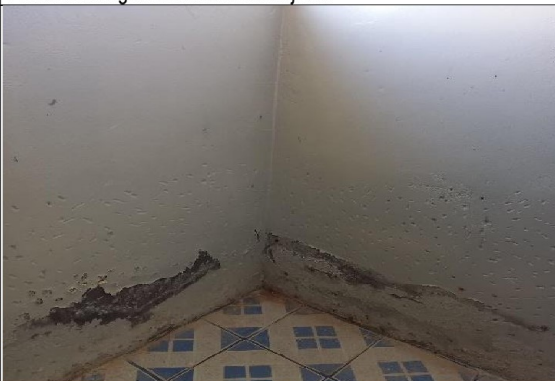
Filtración de agua en la pared del baño de varones.
