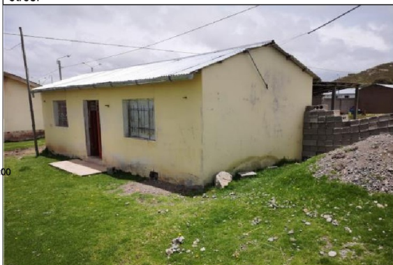
Aula se Psicomotriz exteriormente presenta desniveles en el piso, humedad en los cimientos.
