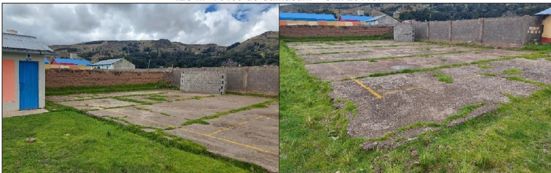
Un tramo del cerco perimétrico de la institución construido con adobe y el resto con bloqueta sin revestimiento ni pintado interior
