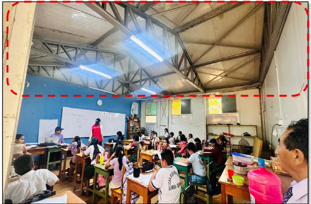
Imagen n.º 24 Techo aula ambiente prefabricado
