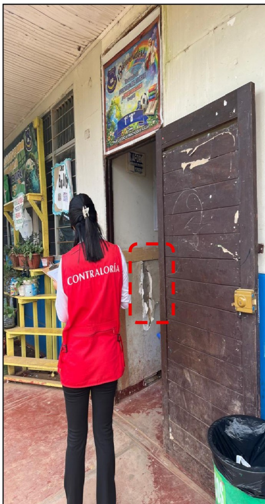
Imagen n.º 2 Vista de pared de aula con aberturas
