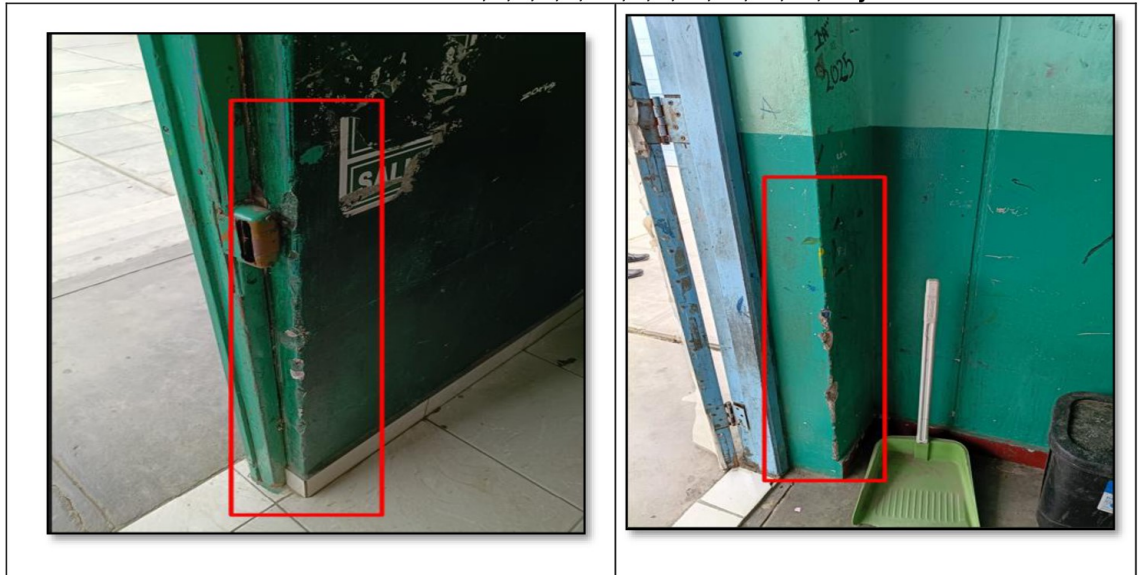
En la totalidad de los salones evidencia desprendimiento de tarrajeo
