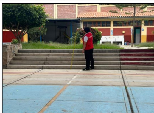
No se cuenta con rampas para acceso de la losa deportiva hacia los servicios higiénicos y aulas de inicial – I.E 86066 Mártires Miguel y Zbigniew
