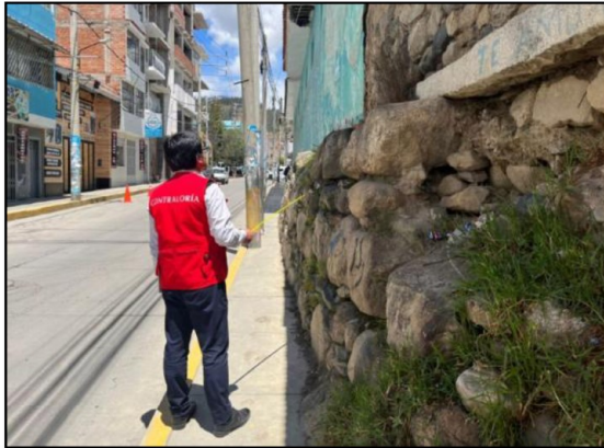
Humedecimiento y presencia de hierbas en la base del cerco perimétrico – I.E 86017 Sabio Antonio Raimondi
