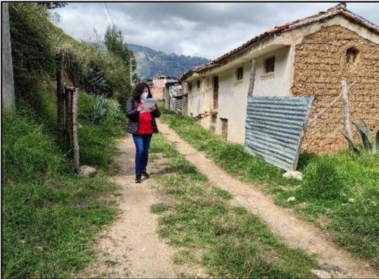
La vía de acceso a la I.E 86104 Augusto Alba Herrera no cuenta con Rampa
