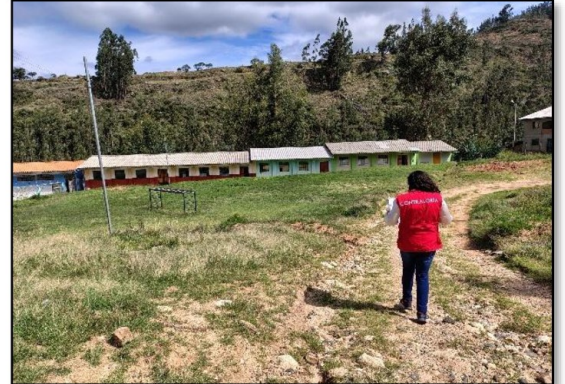
La vía de acceso a la I.E 86104 Augusto Alba Herrera no cuenta con Rampa
