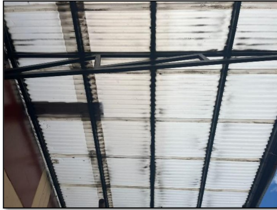
Los bordes del techo que cubre el patio presentan orificios visibles I.E N° 86694 "Fray Martin Milagroso"
