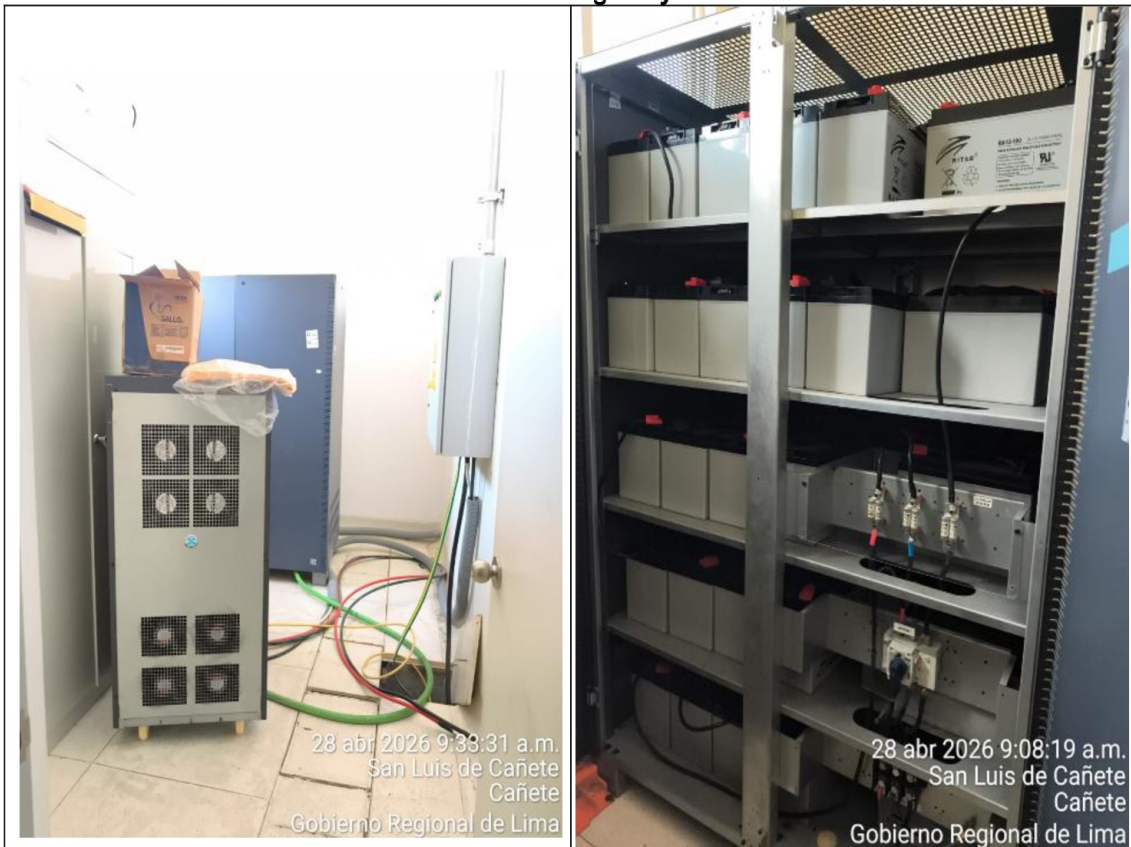
Área Central de UPS del tomógrafo, conformado por el tablero de energía, banco de baterías y equipo UPS.
