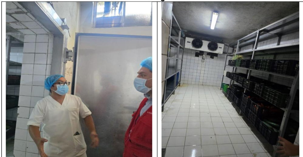
Cámara de verduras en malas condiciones, sin sistema de refrigeración operativo y destinada a uso temporal.
