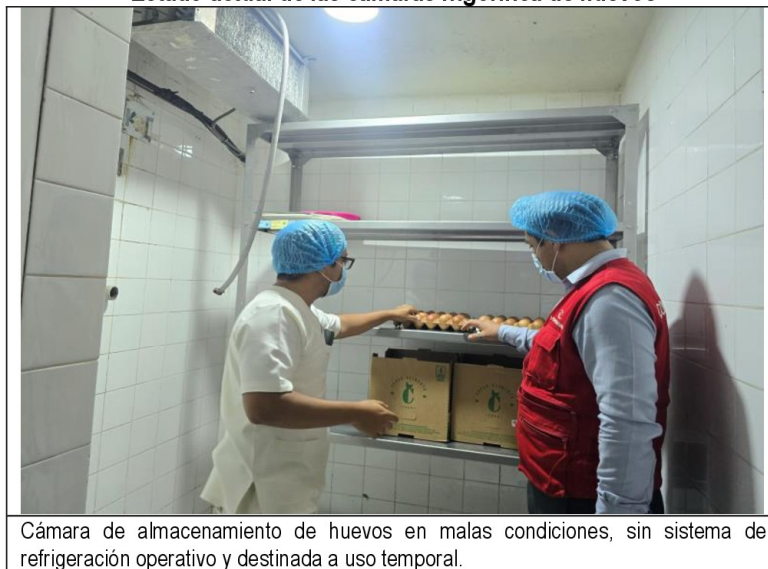
Imagen n.º 5 Estado actual de las cámaras frigorífica de huevos
