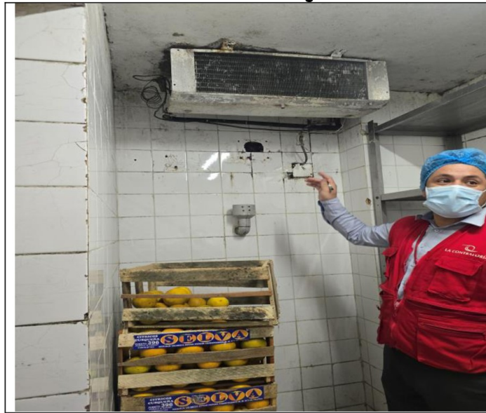
Cámara de almacenamiento de frutas en malas condiciones, sin sistema de refrigeración operativo y destinada a uso temporal.
