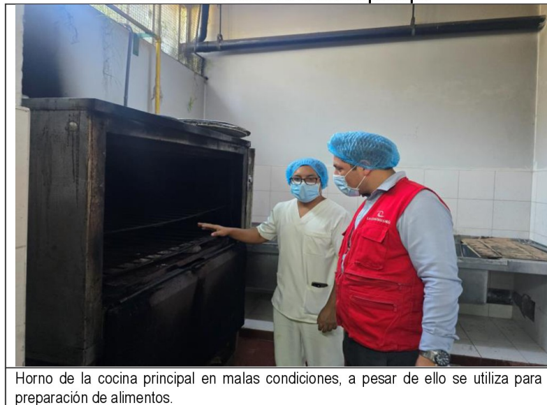
Condiciones del horno de la cocina principal
