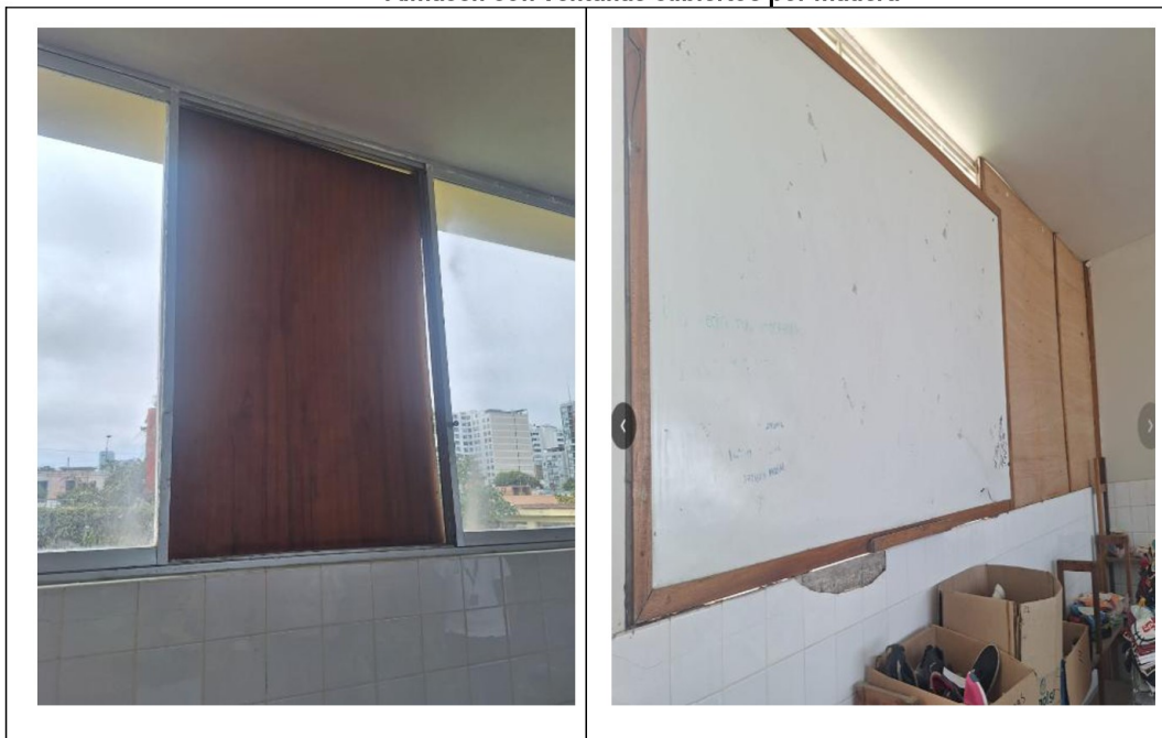
Imagen n.º 4 Almacén con ventanas cubiertos por madera
